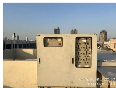
ตู้ควบคุมระบบระบายอากาศ
